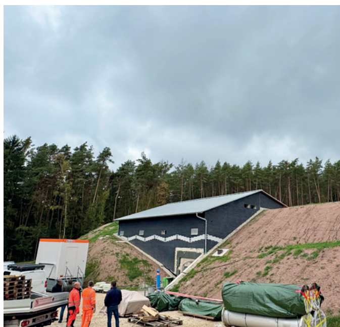
Von Außen sieht man nur das Betriebsgebäude am Westenberg. Die großen Wasserkammern liegen unterirdisch.
